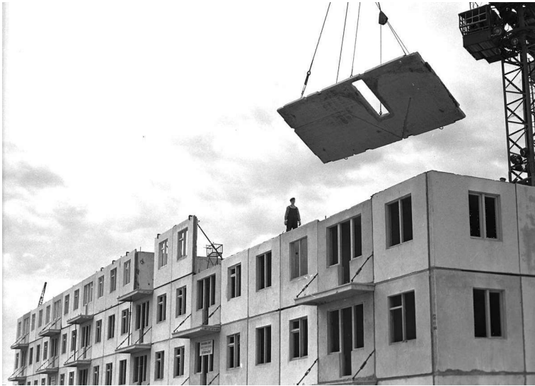
Строительство первого крупнопанельного дома. 1962. ЦГА КФФД КР
