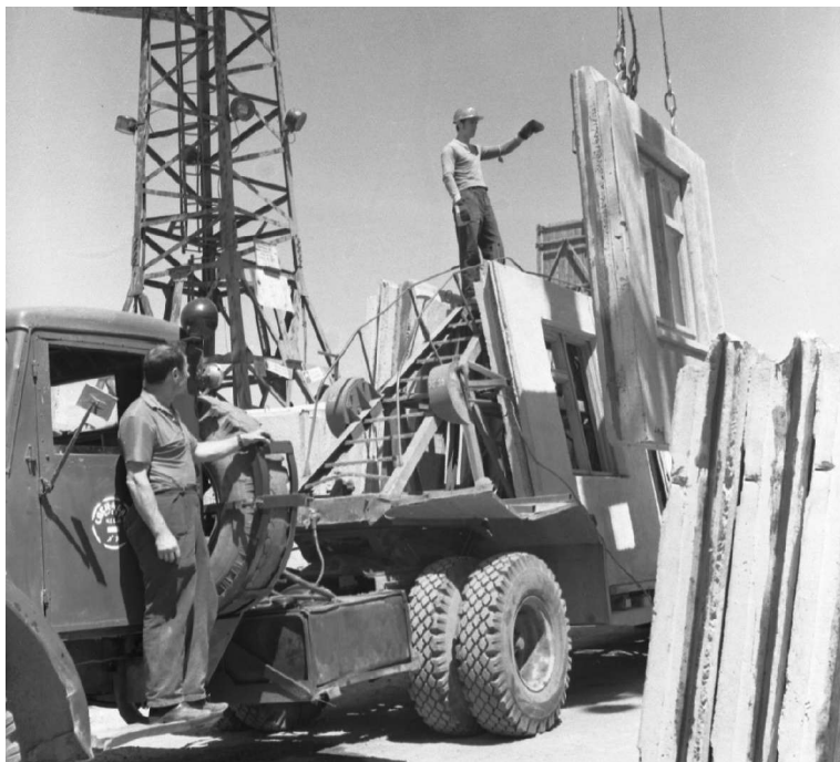
Фрунзенский ДСК. Погрузка наружных стеновых панелей на панелевоз на складе готовой продукции для отправки на стройплощадку. 1972. ЦГА КФД КР
